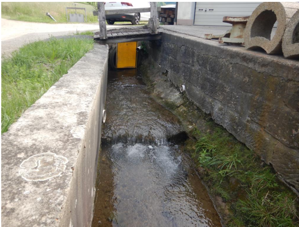
Abbildung 6: Durchlass am Aschbach (Abschnitt 85) mit Straßenschild als Barriere
